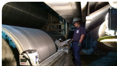
Obróbka maszynowa powierzchni jest stosowana w przypadku silnego odchylenia profilu powierzchni lub dużego uderzenia. (do 1 mm/Ø)
